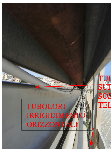
Figura 27 Tubolare superiore fissaggio telo
