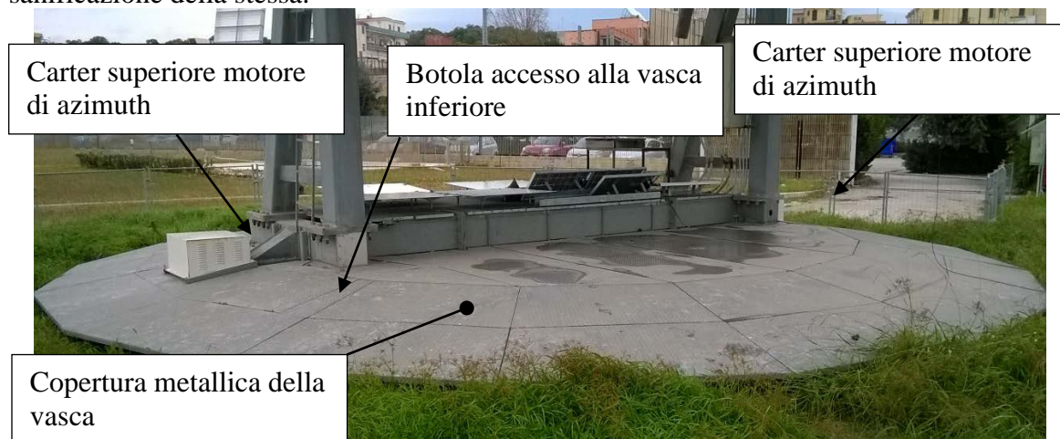
Fig8- Parte inferiore della struttura dell'eliostato che ruota intorno all'asse centrale e verticale: sono visibili gli alloggiamenti dei motoriduttori, la copertura metallica che copre la vasca e la botola di accesso
