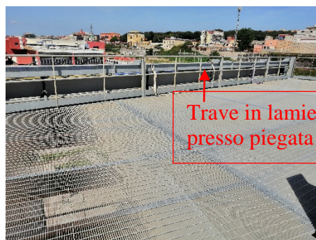
Figura 26 Trave di lamiera presso piegata di ancoraggio telo
