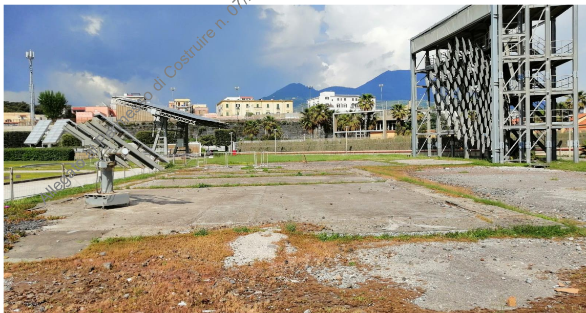
Fig.14-Piattaforma in cls su cui verrà ancorato l'impianto a inseguimento monoassiale da 10kW-vista da OVEST
