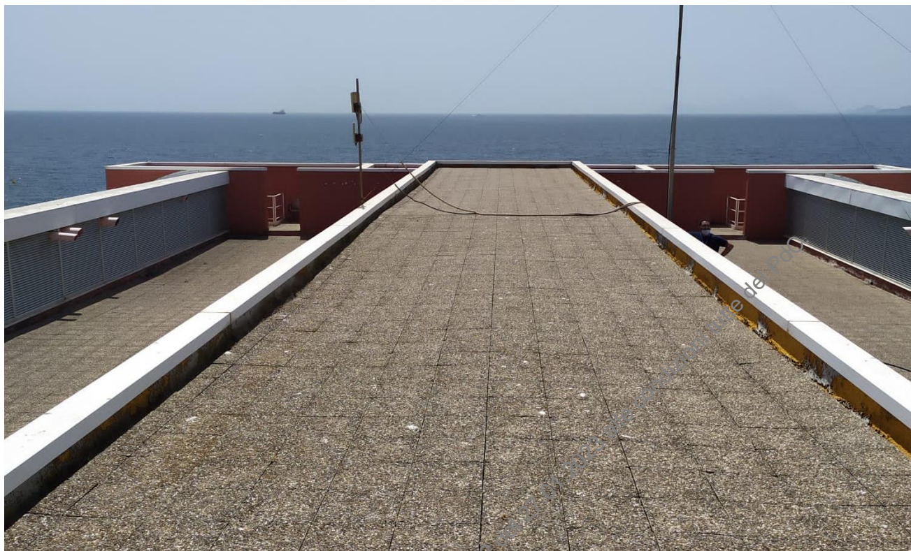
Fig.11-Copertura piana dell'edificio 1 su cui è prevista l'installazione dei generatori microeolici - Vista da Est
