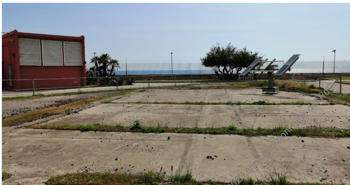
Fig.13-Piattaforma in cls su cui verrà ancorato l'impianto a inseguimento monoassiale da 10kW-vista da EST
